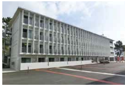
写真4 竣工した新生明専寮（旧北寮）
