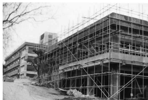
写真2 建設中の新寮（昭和43年）
